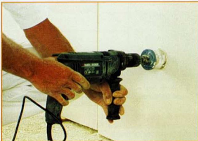
Photo 2 : Scie cloche pour les boîtiers électriques
